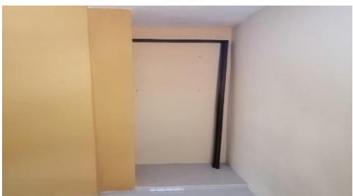
Adecuaciones al espacio de bodega
